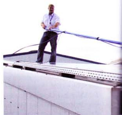
Die FD Friedrich GmbH hat 1.470 Quadratmeter Fläche mit Solarmodulen auf dem Dach. Rund 90 Quadratmeter können so in anderthalb Stunden gereinigt werden
